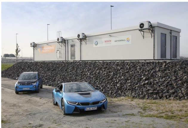
Figure 13 : Stockage stationnaire de 2,8 MWh / 2MW de batteries de seconde vie de BMW i3 à Hambourg 47
