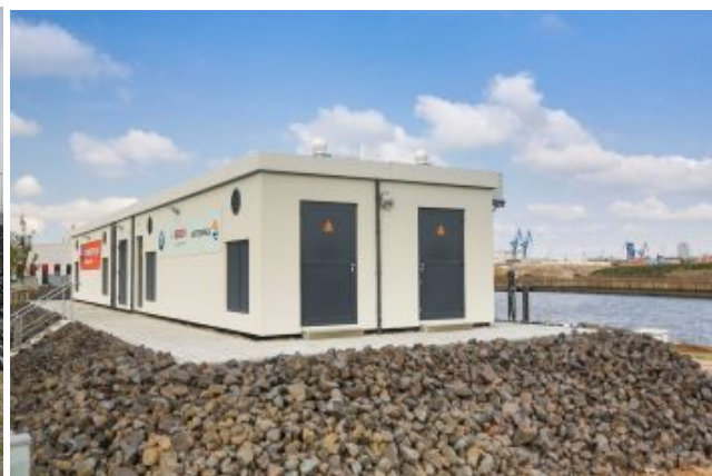
Figure 13 : Stockage stationnaire de 2,8 MWh / 2MW de batteries de seconde vie de BMW i3 à Hambourg 47
