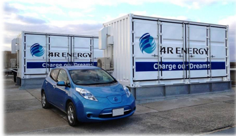
Figure 14 : Premier système de stockage stationnaire avec des batteries Li-ion de seconde vie
