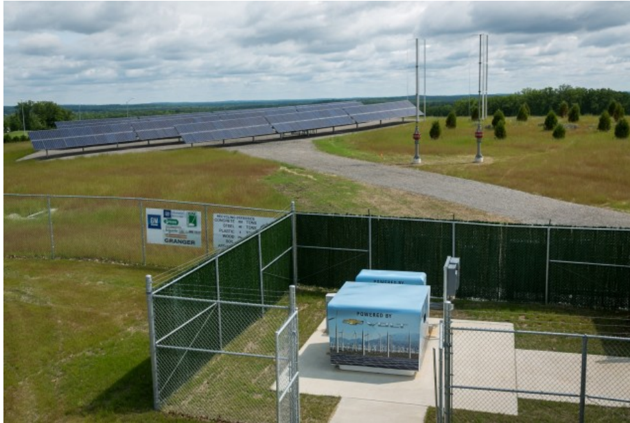
Figure 15 : Système de stockage de batteries usagées issues de Chevrolet Volt pour une application « micro-grid » sur le site de GM à Mildford
